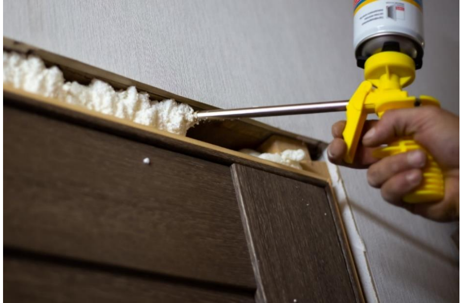
BILD: iStock – Einschäumen der Lücke zwischen Tür und Wand mit Polyurethanschaum.
