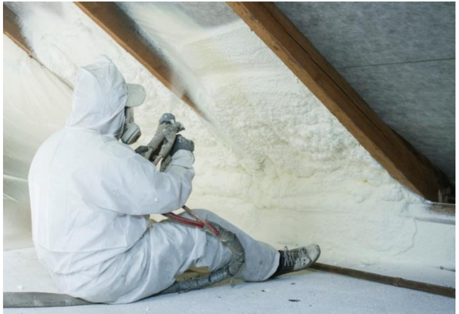
BILD: iStock – Sprühschaumisolierung mit Mehrkomponentenpistole mit Polyurethanschaum.
