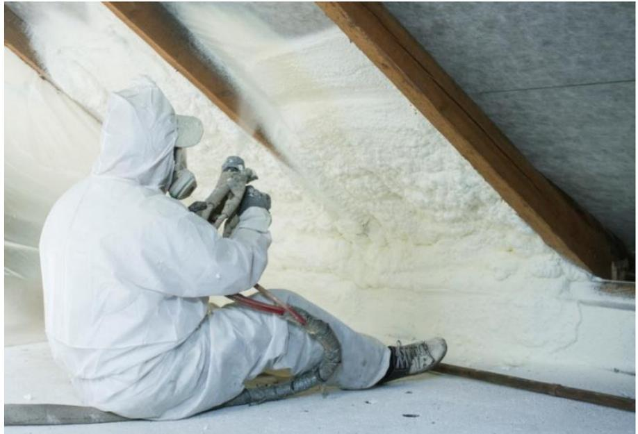
BILD: iStock – Sprühschaumisolierung mit Mehrkomponentenpistole mit Polyurethanschaum.
