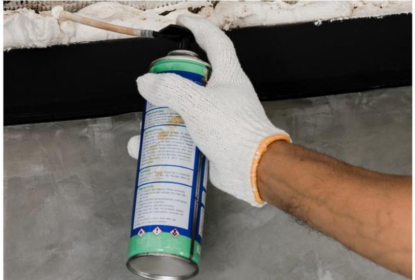
BILD: iStock – Abdichten eines Dachlecks mit Polyurethanschaum
